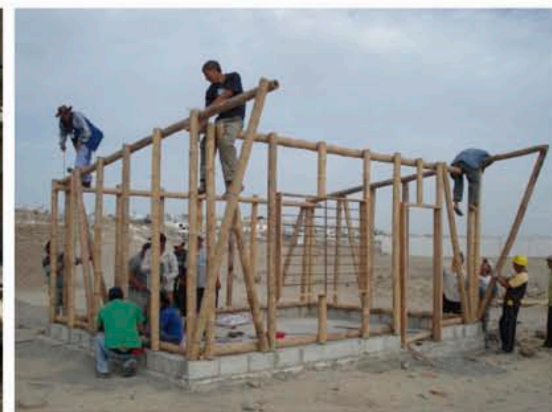
MONTAJE DE PANELES PREFABRICADOS
