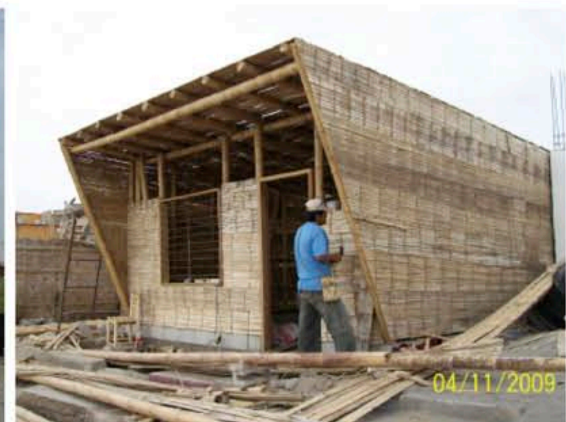
CERRAMIENTO DE PANELES Y CUBIERTA
